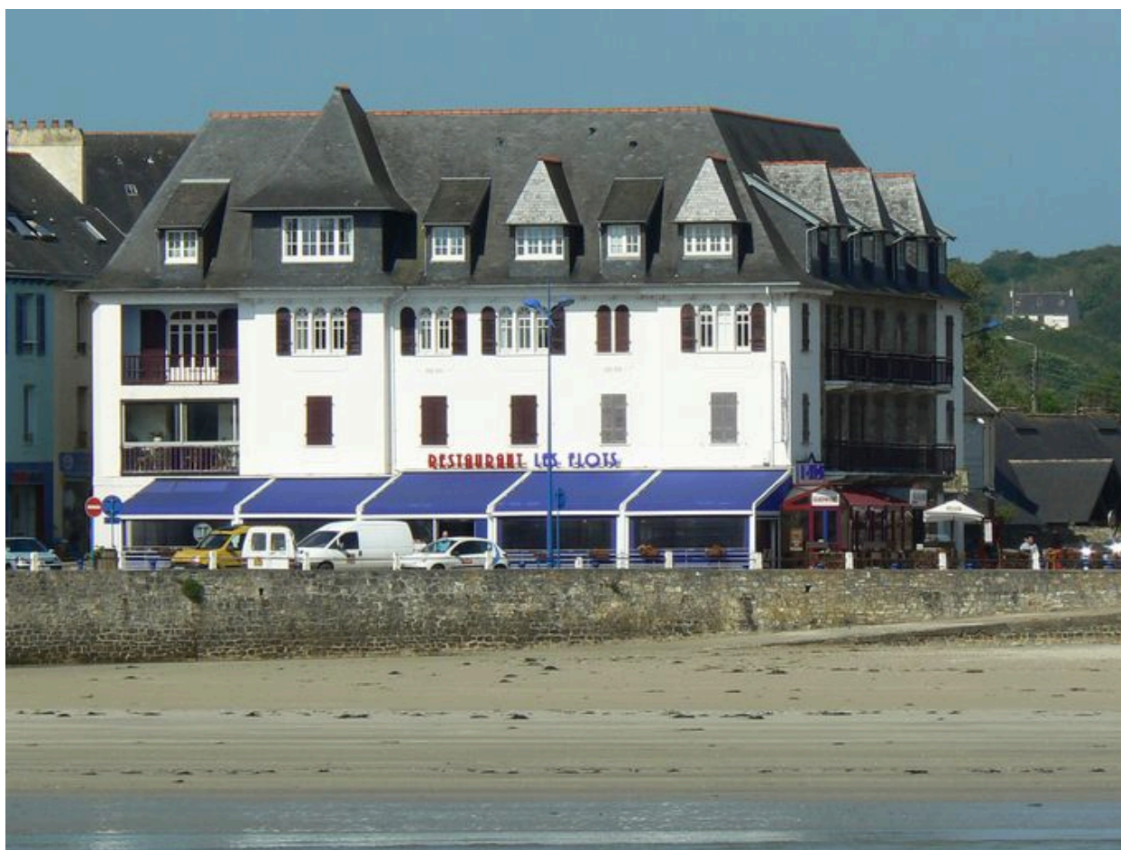
Vue générale de l'ancien Hôtel Sainte-Marine, aujourd'hui immeuble Les Flots
