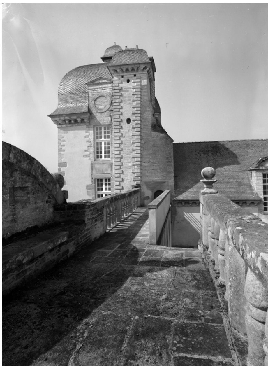
Galerie : vue générale
