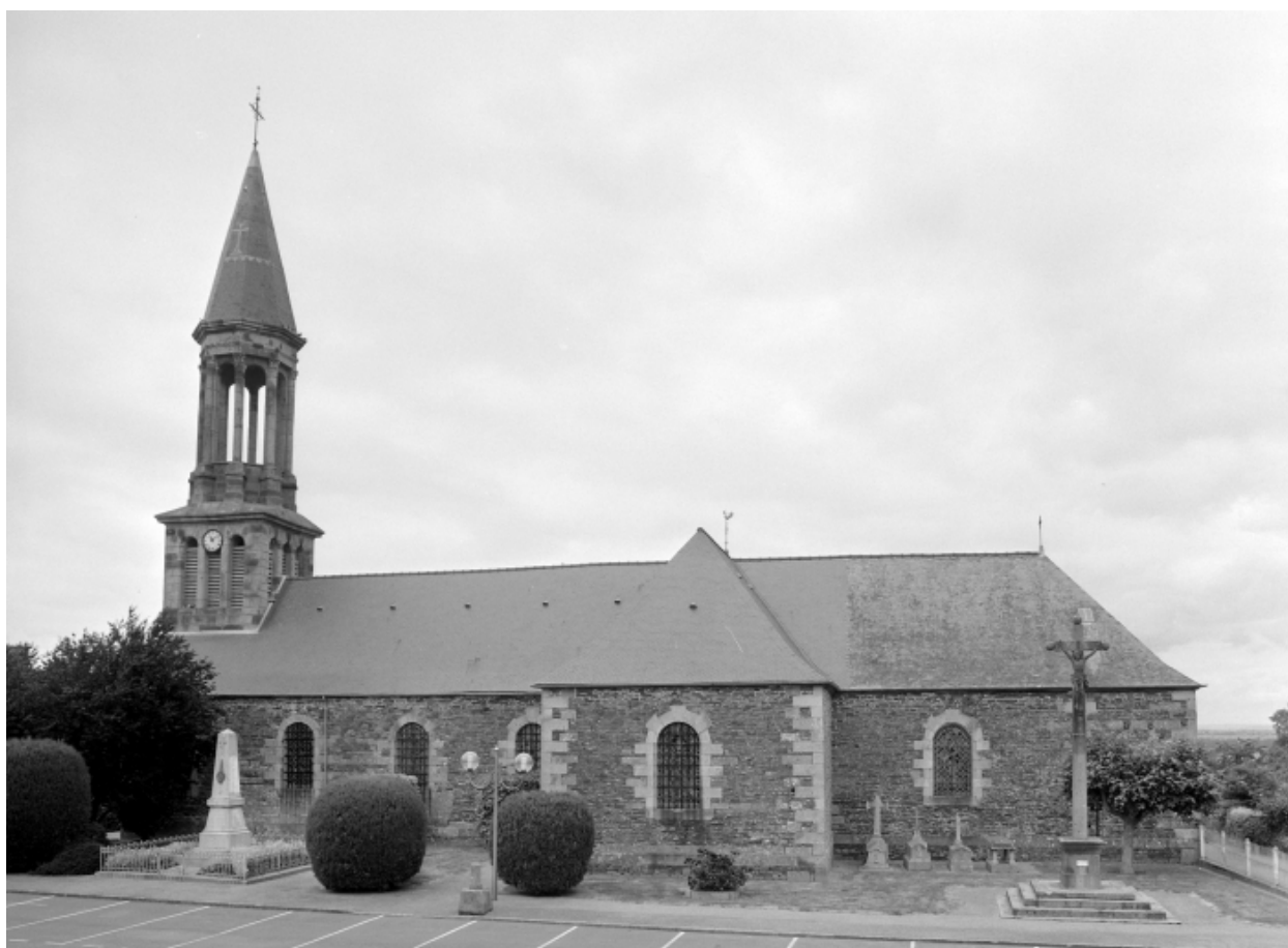
Elévation Sud : vue générale
