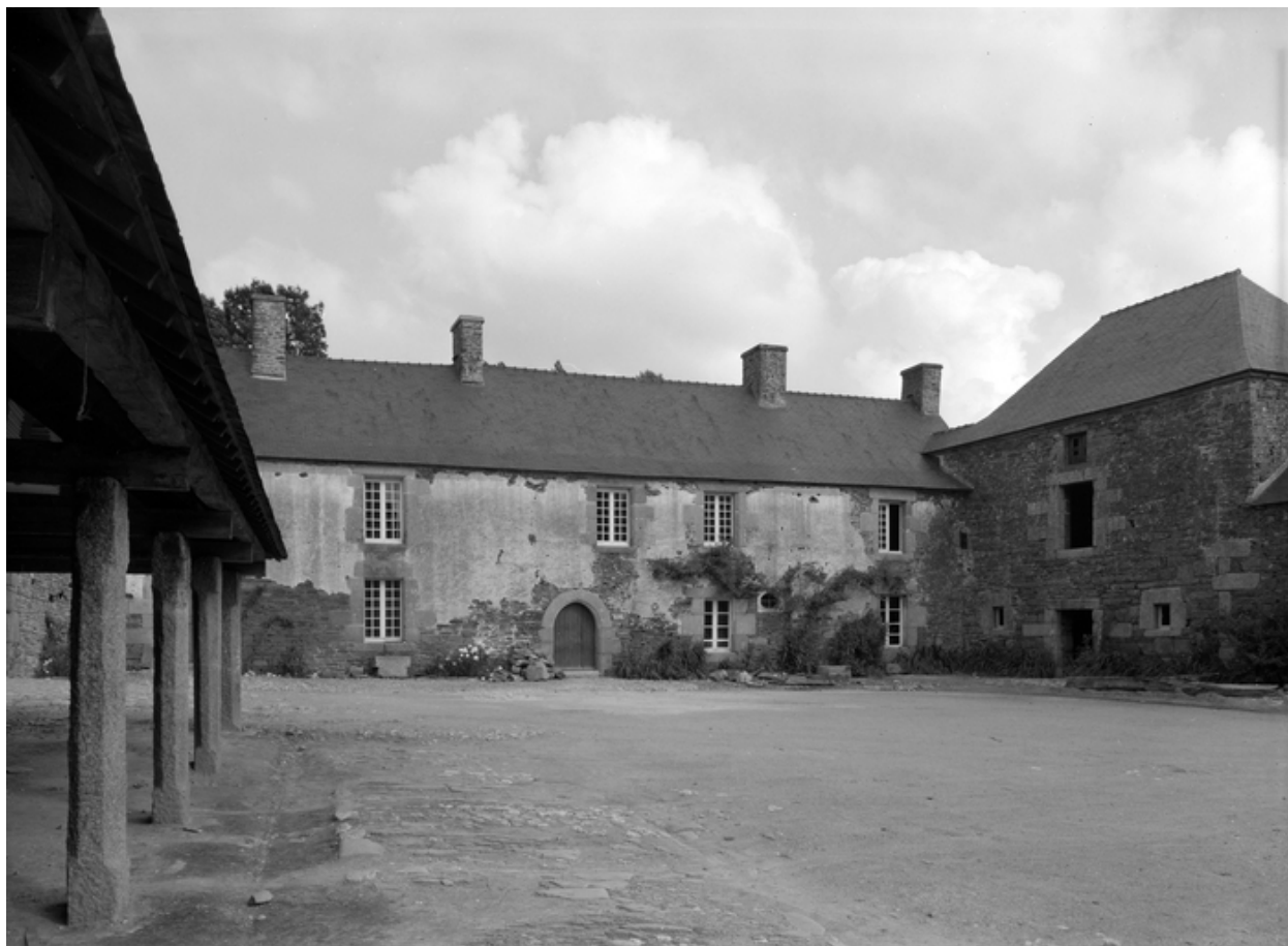
Bâtiment C : élévation sud
