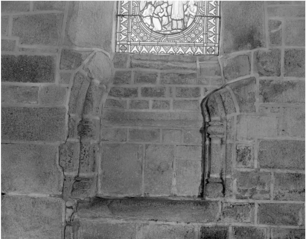
Choeur, bas-côté nord, niche
