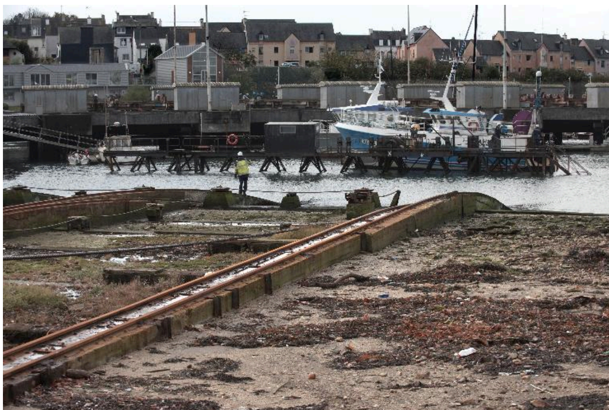
Slipway, rails et câbles
