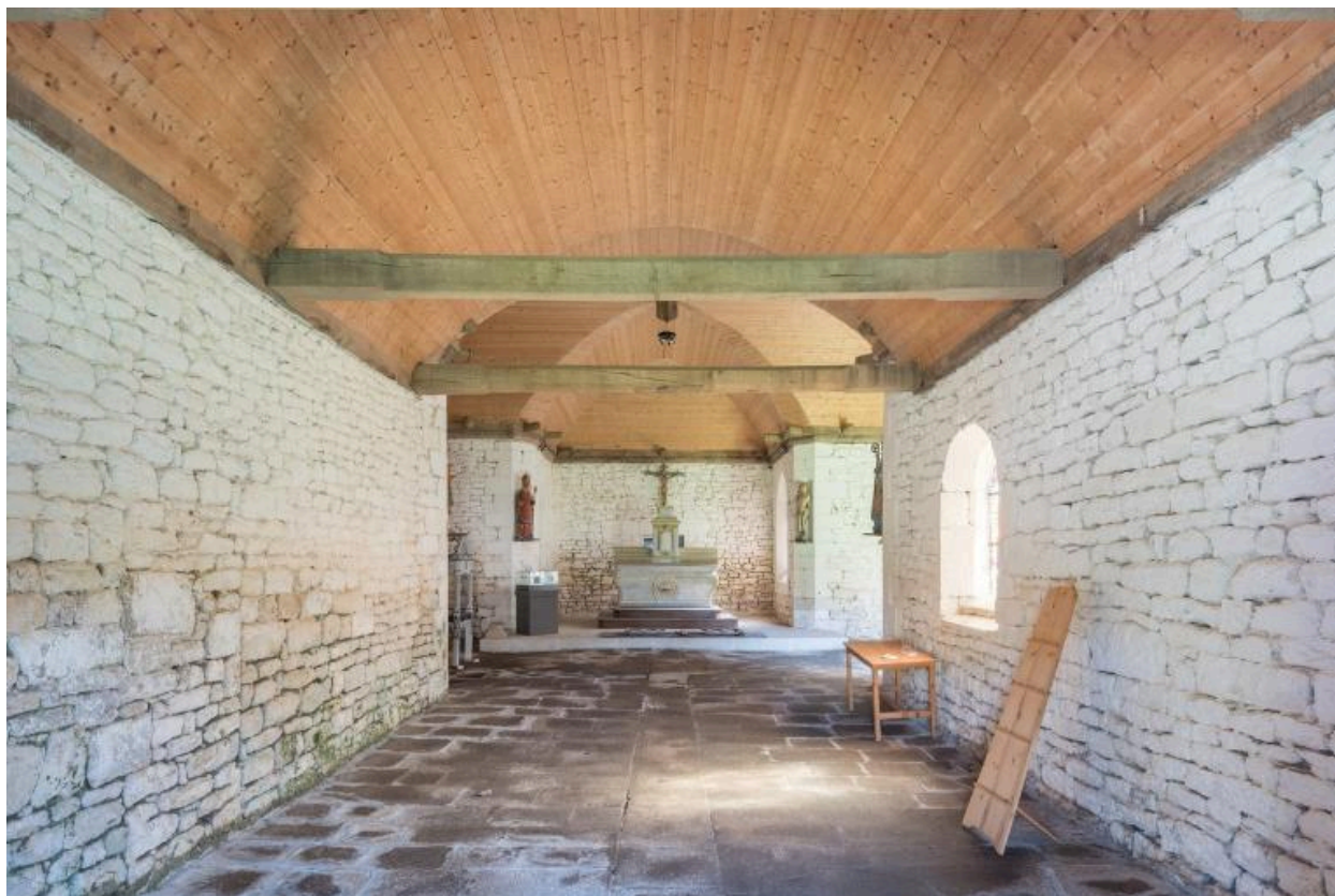
Vue depuis le fond de la nef vers le choeur de la chapelle
