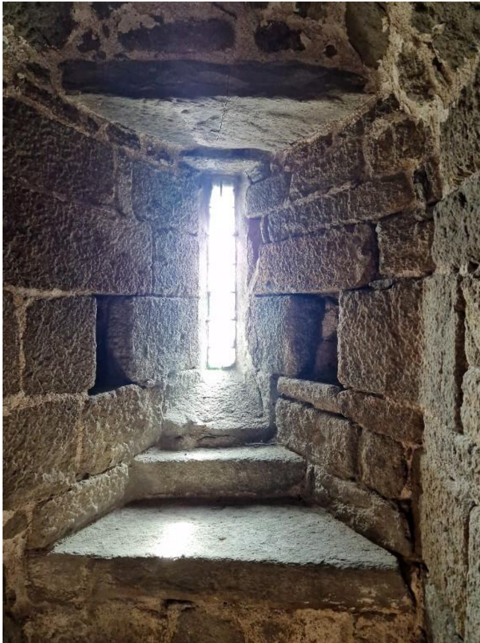
Vue intérieure de la tour Solidor : niveau intermédiaire accessible par quelques marches depuis le rez-de-chaussée, latrines éclairées par une arbalétrière orientée vers le sud
