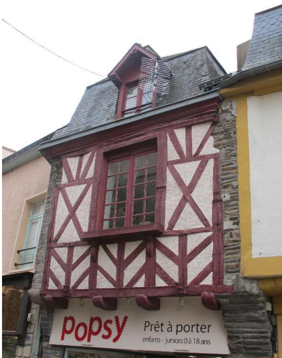
Elévation nord-ouest : le premier étage (état en 2012)
