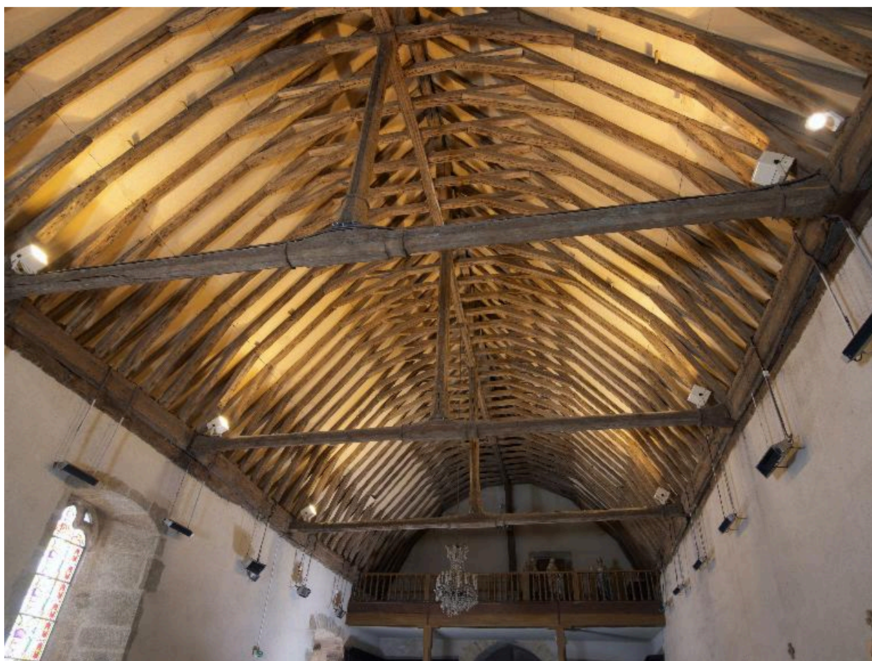
Vue de la charpente
