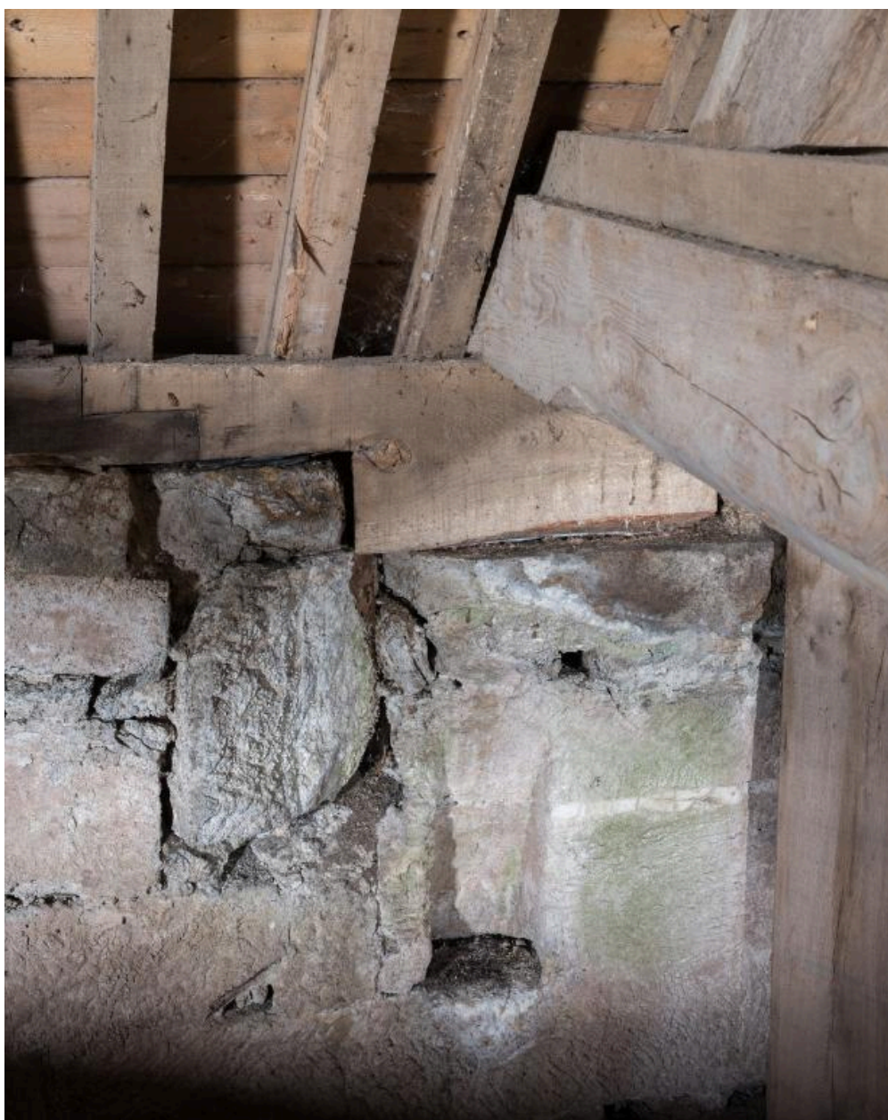
Vue détail : vestige d'empochement au sommet du mur sud de la travée droite du chœur.
