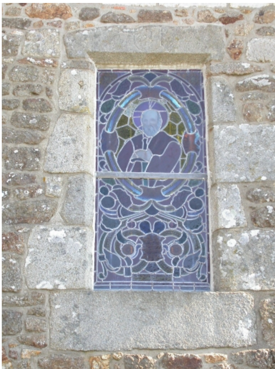
Fenêtre façade sud
