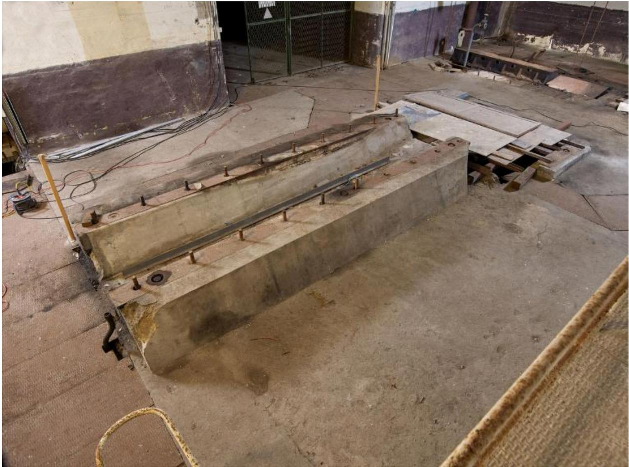
Locaux techniques, partie sud, rez-de-chaussée, grande pièce de la centrale électrique : socle en béton armé du générateur (des tiges filetées émergent du socle)
