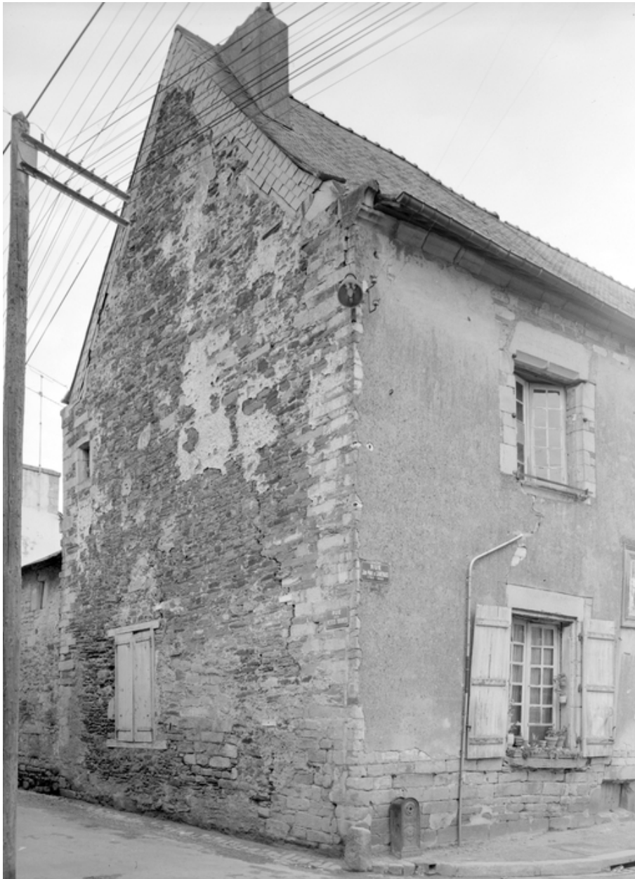
Vue générale de l'angle ouest de la maison.
