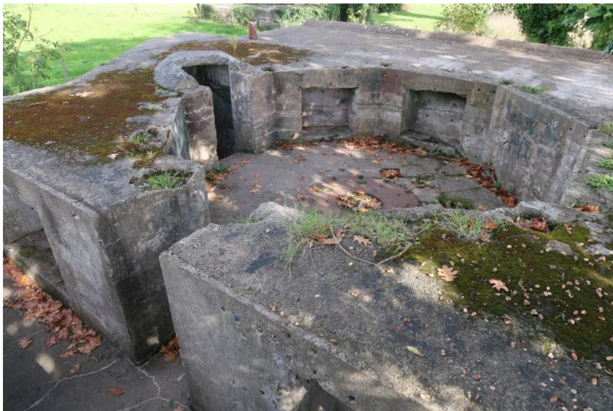
Vue depuis le sud-ouest : cuve du télémètre
