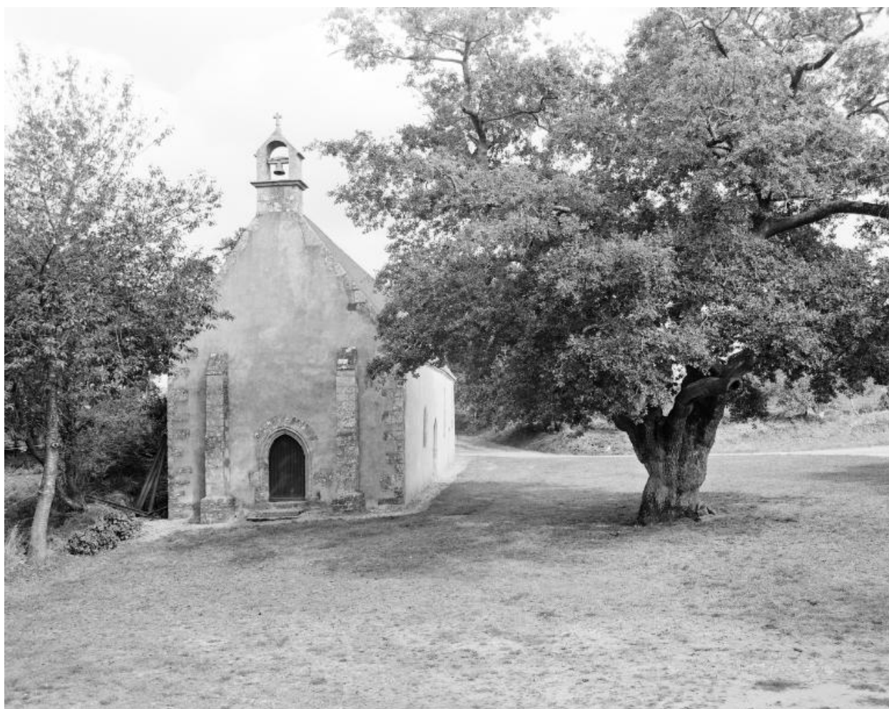
Vue générale ouest.
