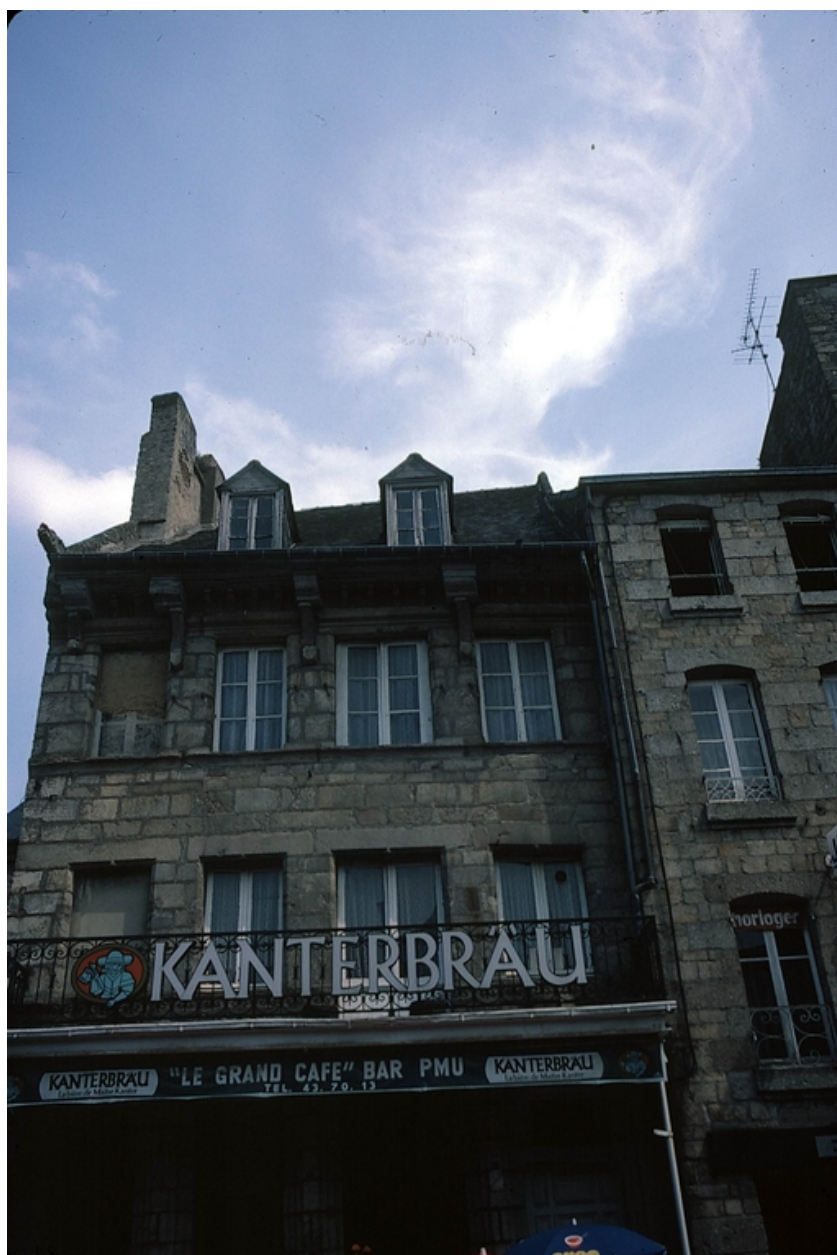
Maison n°4, vue générale.
