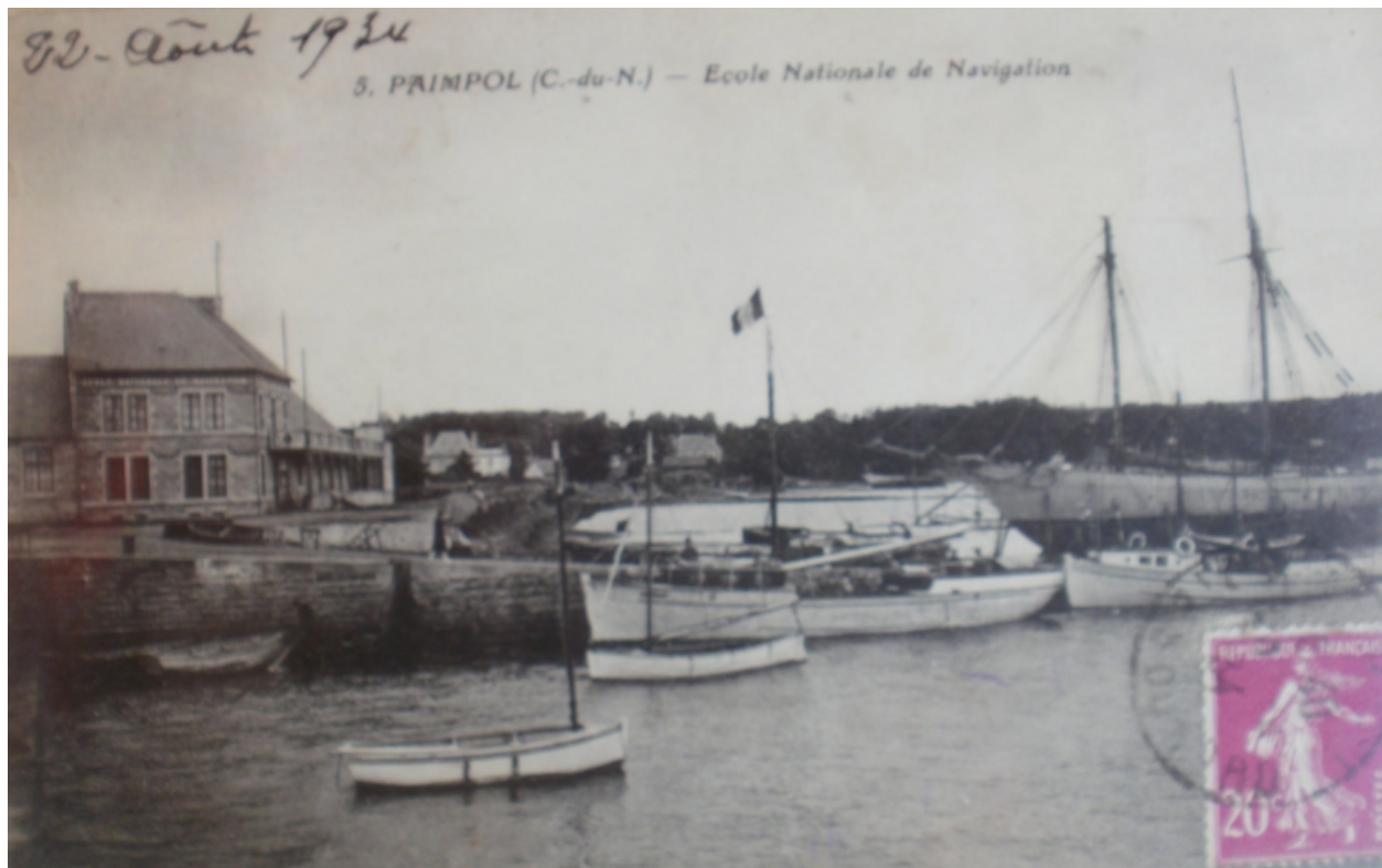
Vue des bâtiments de l'ancienne Hydro devant le quai des Bréhatins, 1934 (carte postale, collection particulière)
