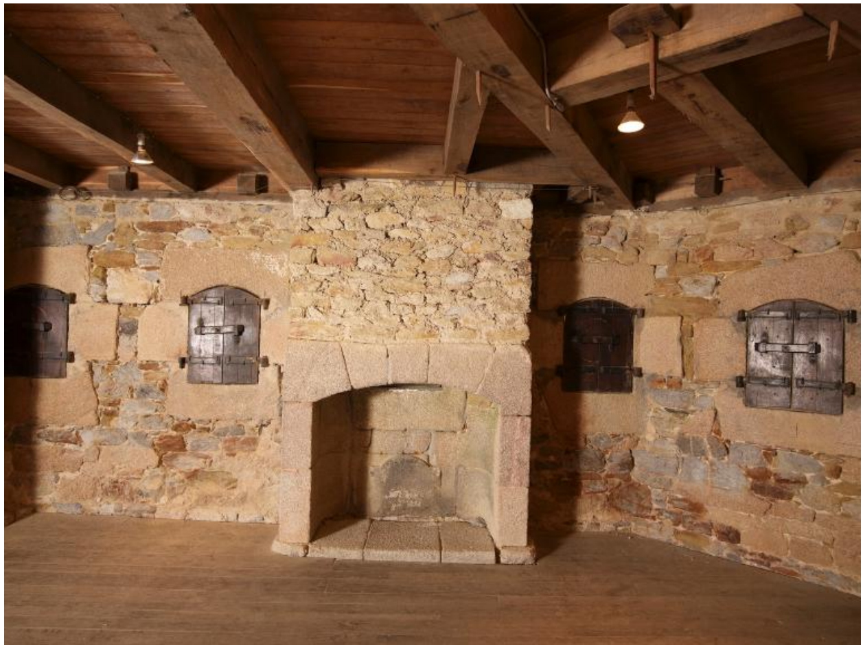
Camaret-sur-Mer : vue de la tour Vauban, troisième niveau, cheminée
