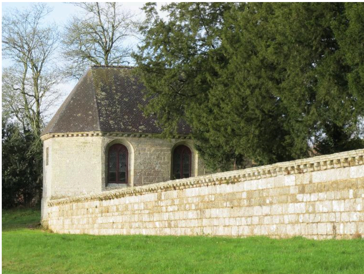
Mur de clôture et chapelle, vue générale sud, état en 2015
