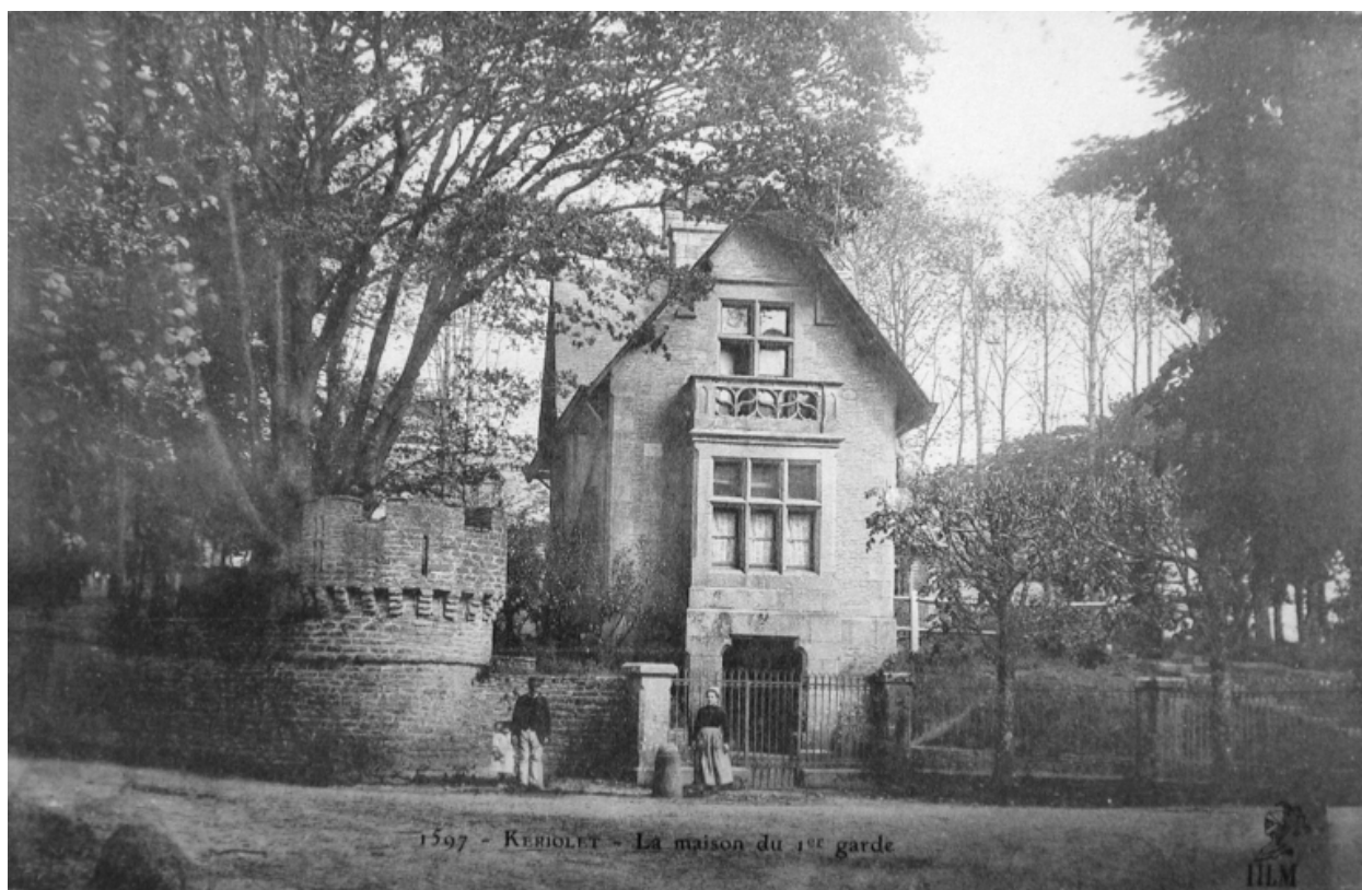
Vue de la première maison de garde
