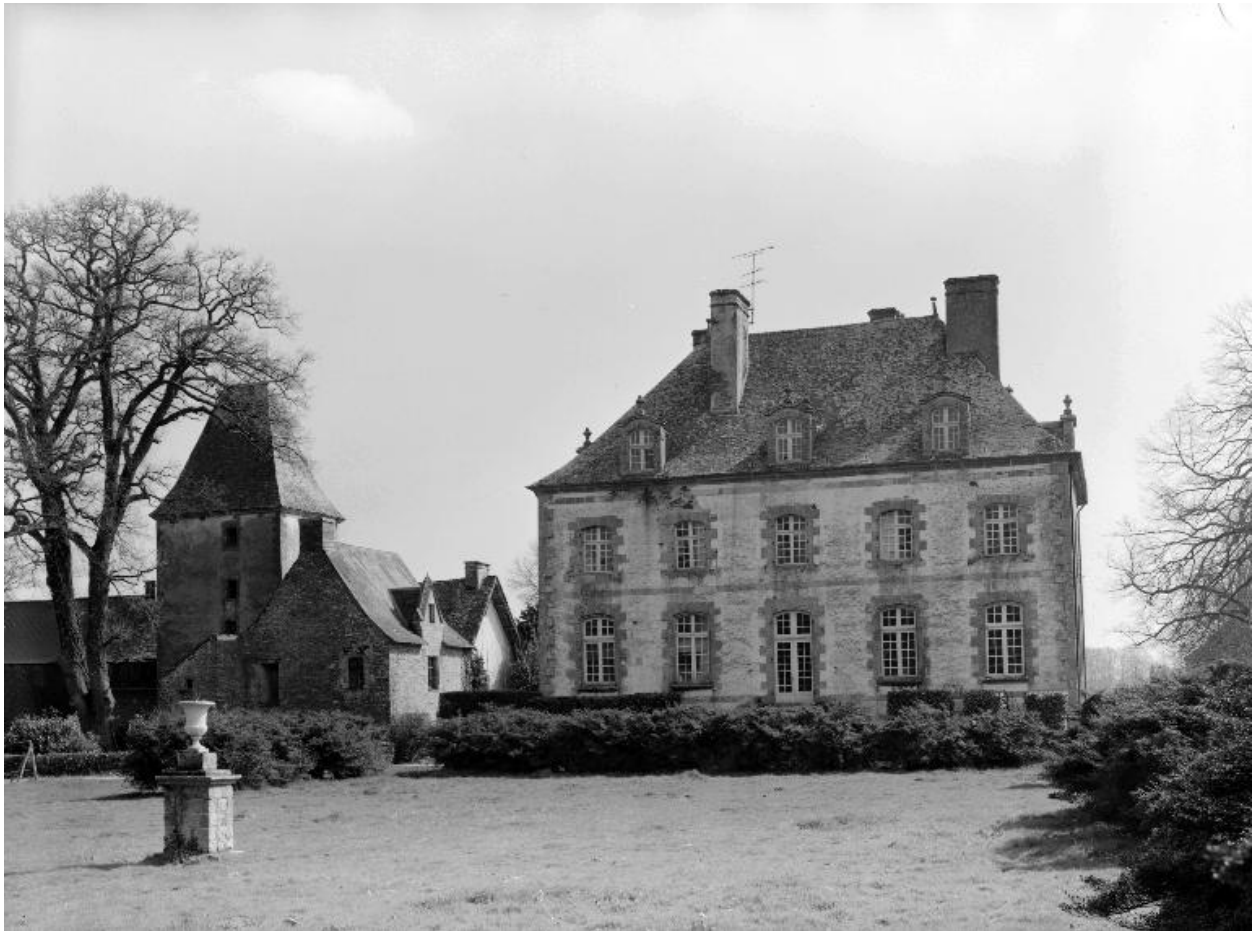
Château, logis : élévation ouest (état en 1984)
