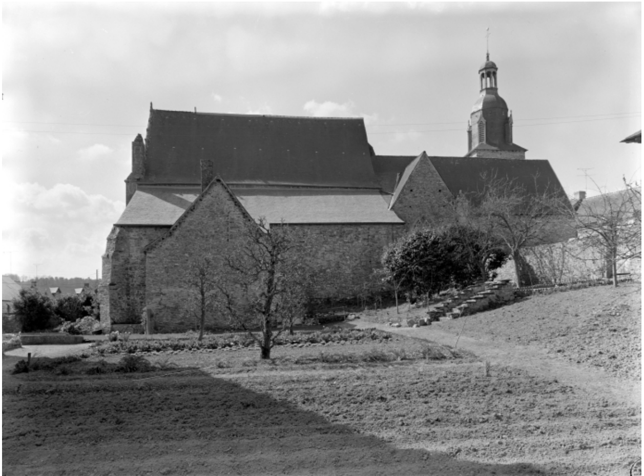
Élévation nord, vue générale prise du jardin du presbytère.
