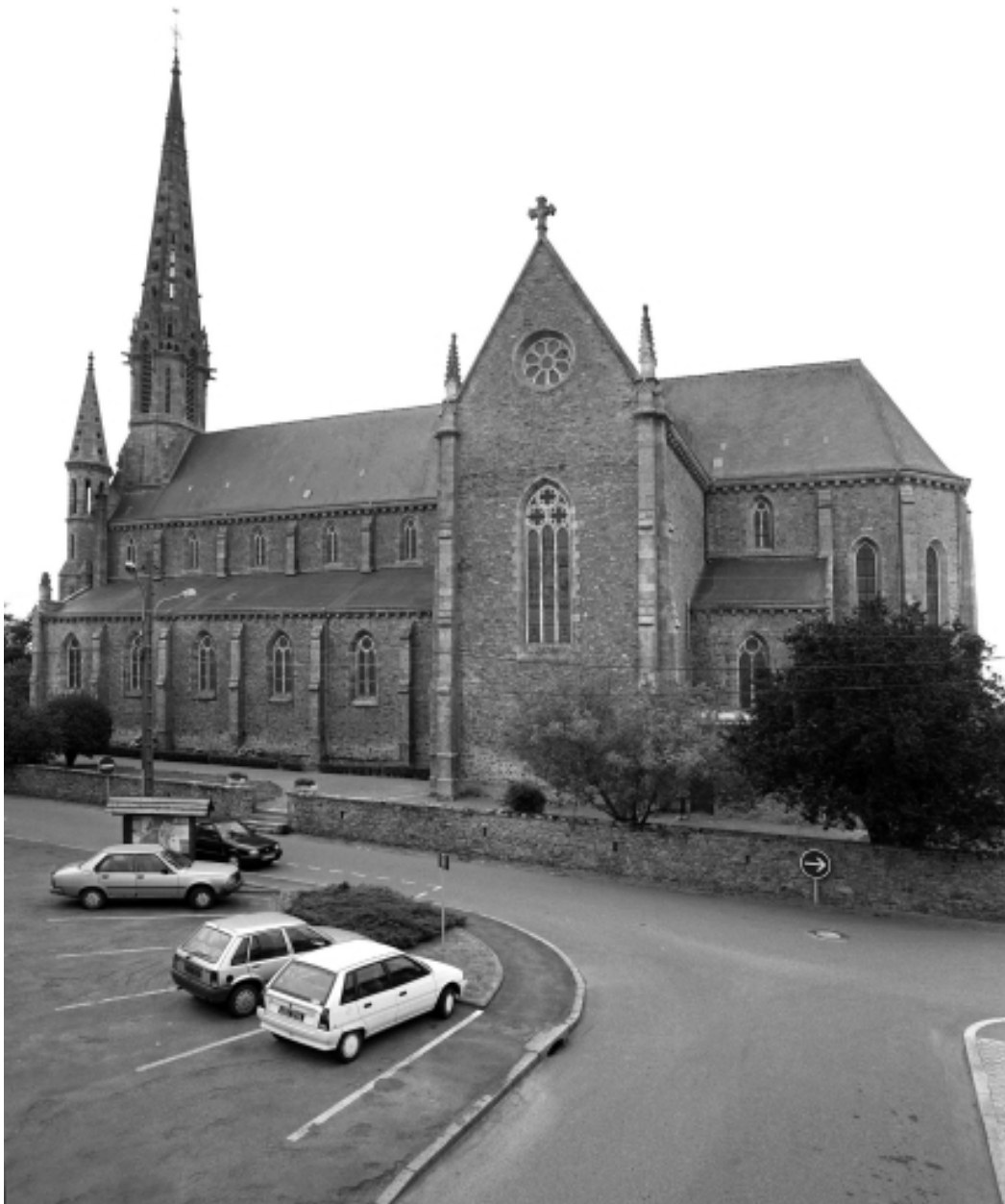
Élévation nord : vue générale
