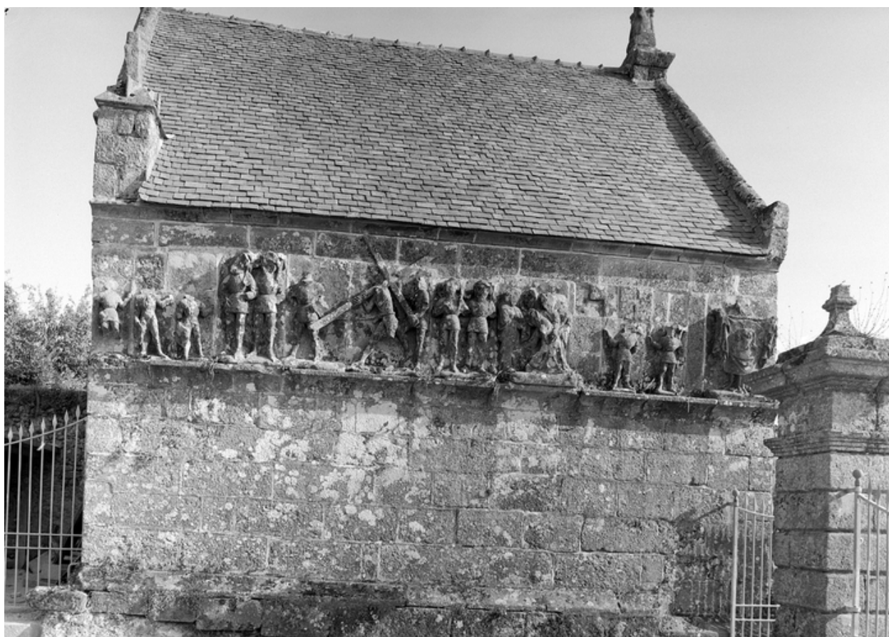
Façade nord, frise : vue générale
