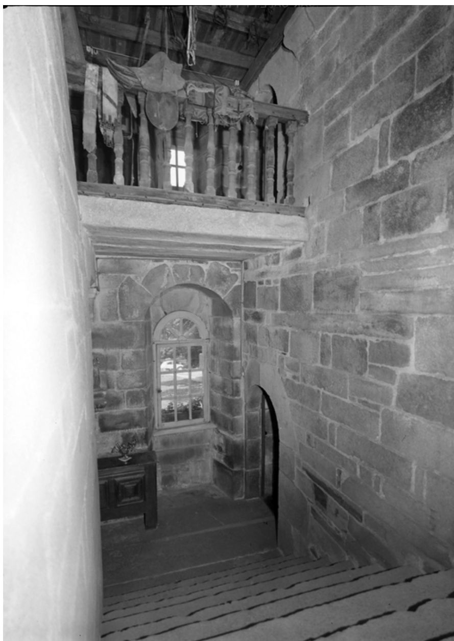
Cage d'escalier : paliers des 1er et 2ème étages
