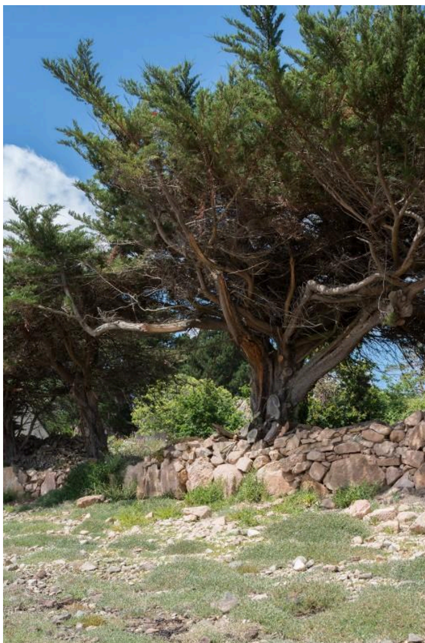
Mur en pierre sèche de l'île Balanec, servant de support à une haie arborée
