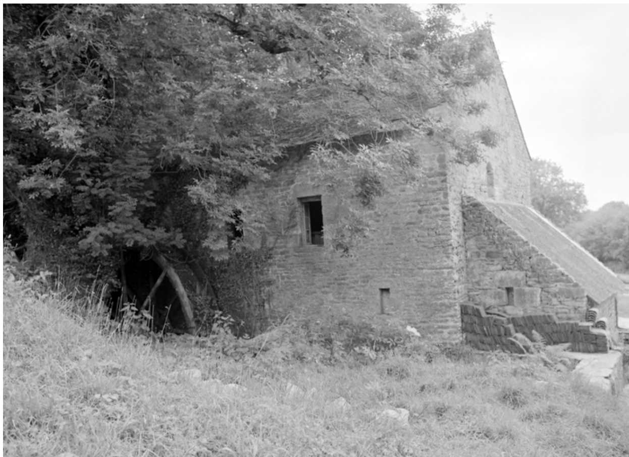
Moulin, vue prise du nord-ouest.
