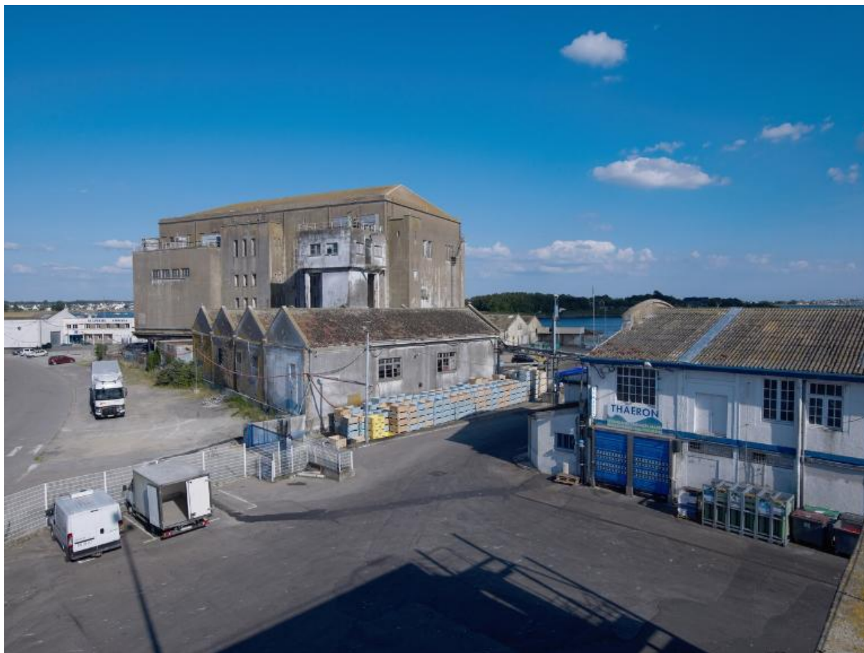
Frigorifique de Keroman, vue générale
