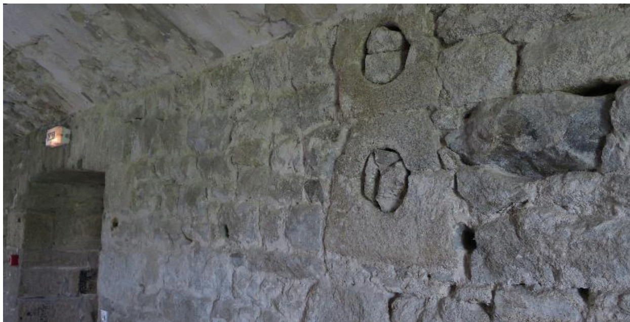
Hœdic, fort central, caserne à l'épreuve, détail d'un conduit de poêle.
