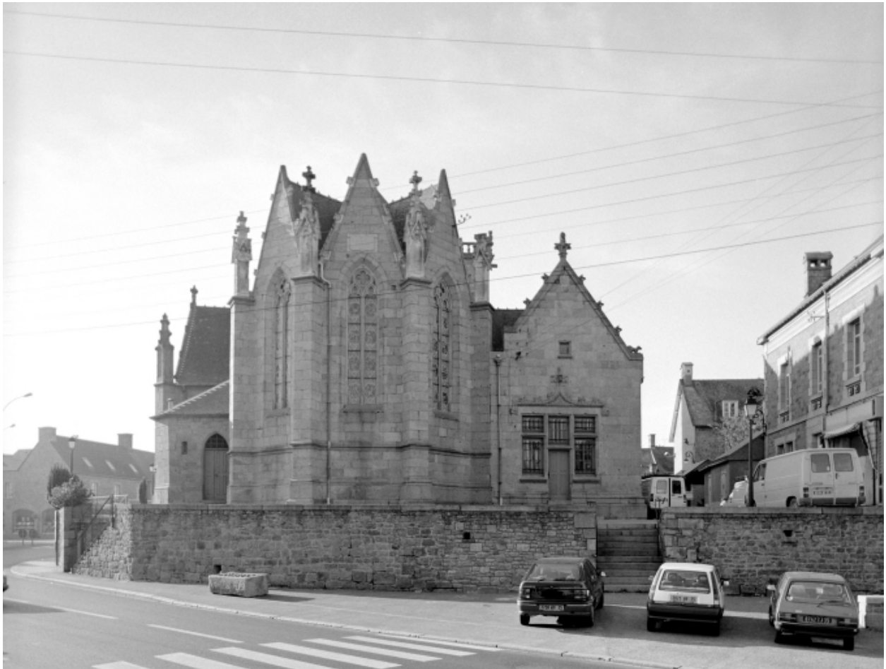
Elévation Est : vue générale
