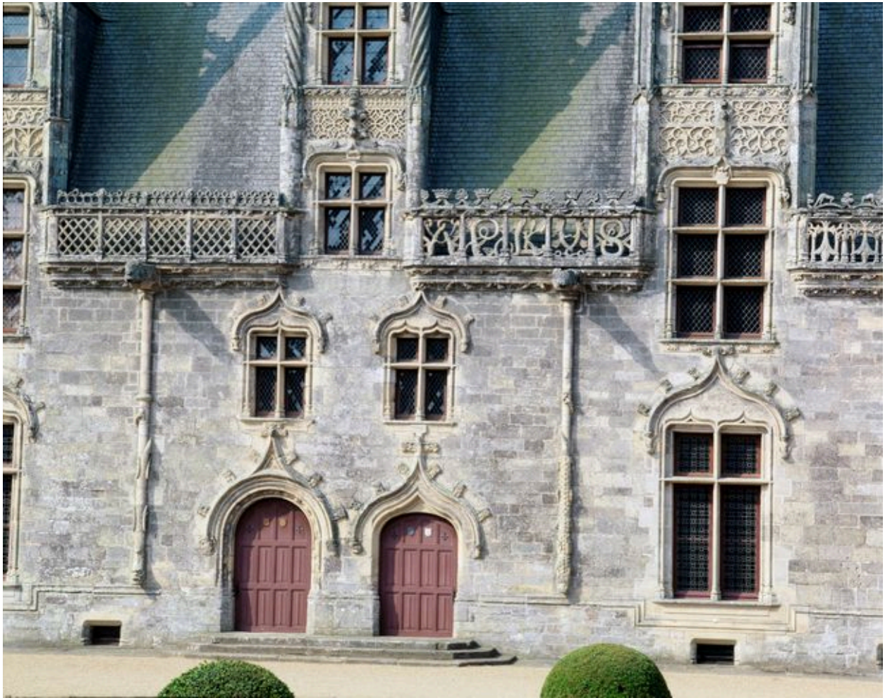
Logis, élévation sur cour, entrée principale : vue rapprochée
