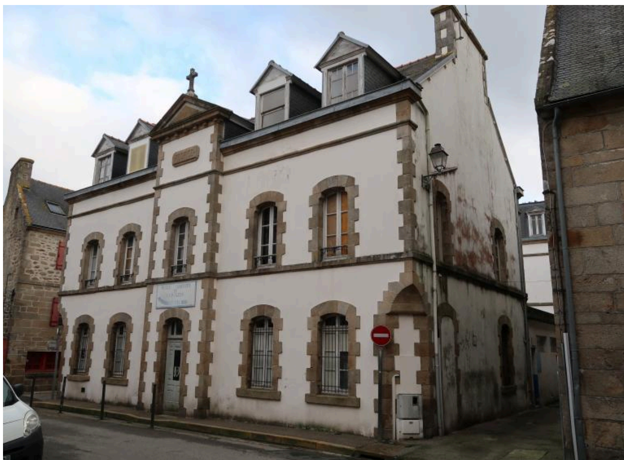
Pavillon ouest, élévation ouest. (2020)
