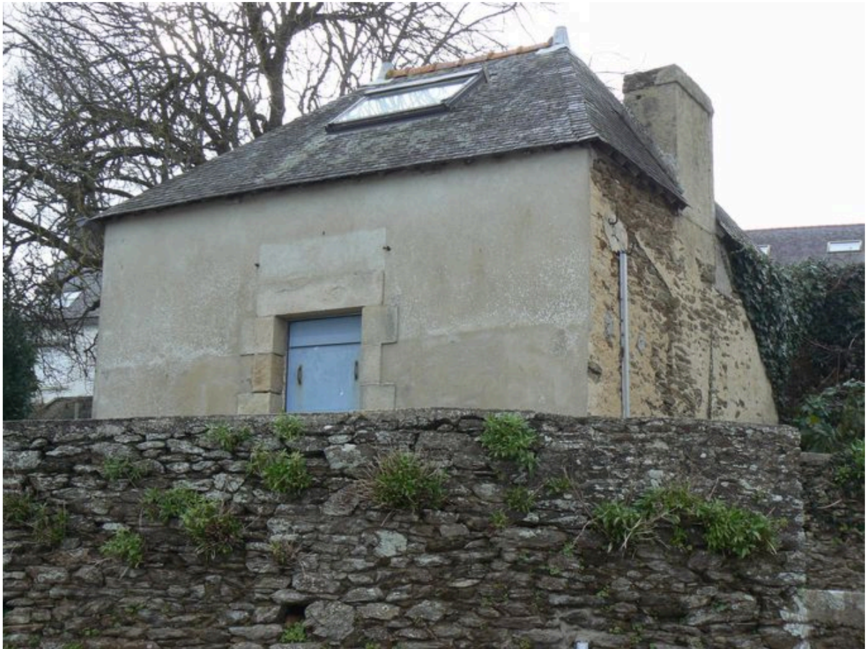
Corps de garde aval vu du quai
