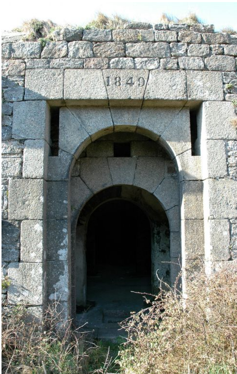
Vue de l'entrée avec le millésime 1849 (état en 2006)
