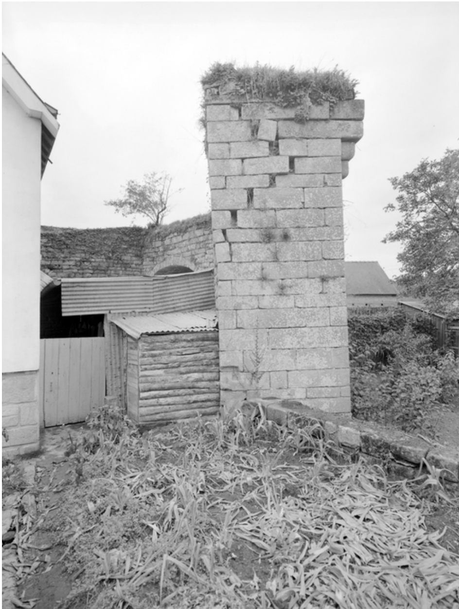
Intérieur de la poterne, vue du sud-est
