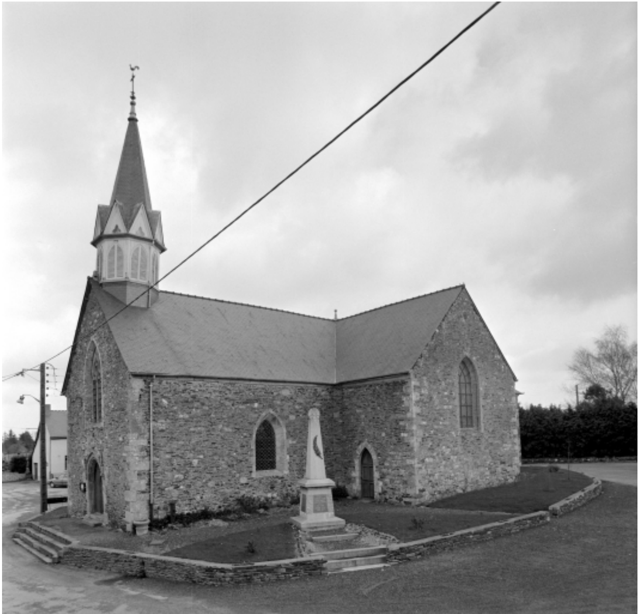
Elévation Sud-Ouest : vue générale.
