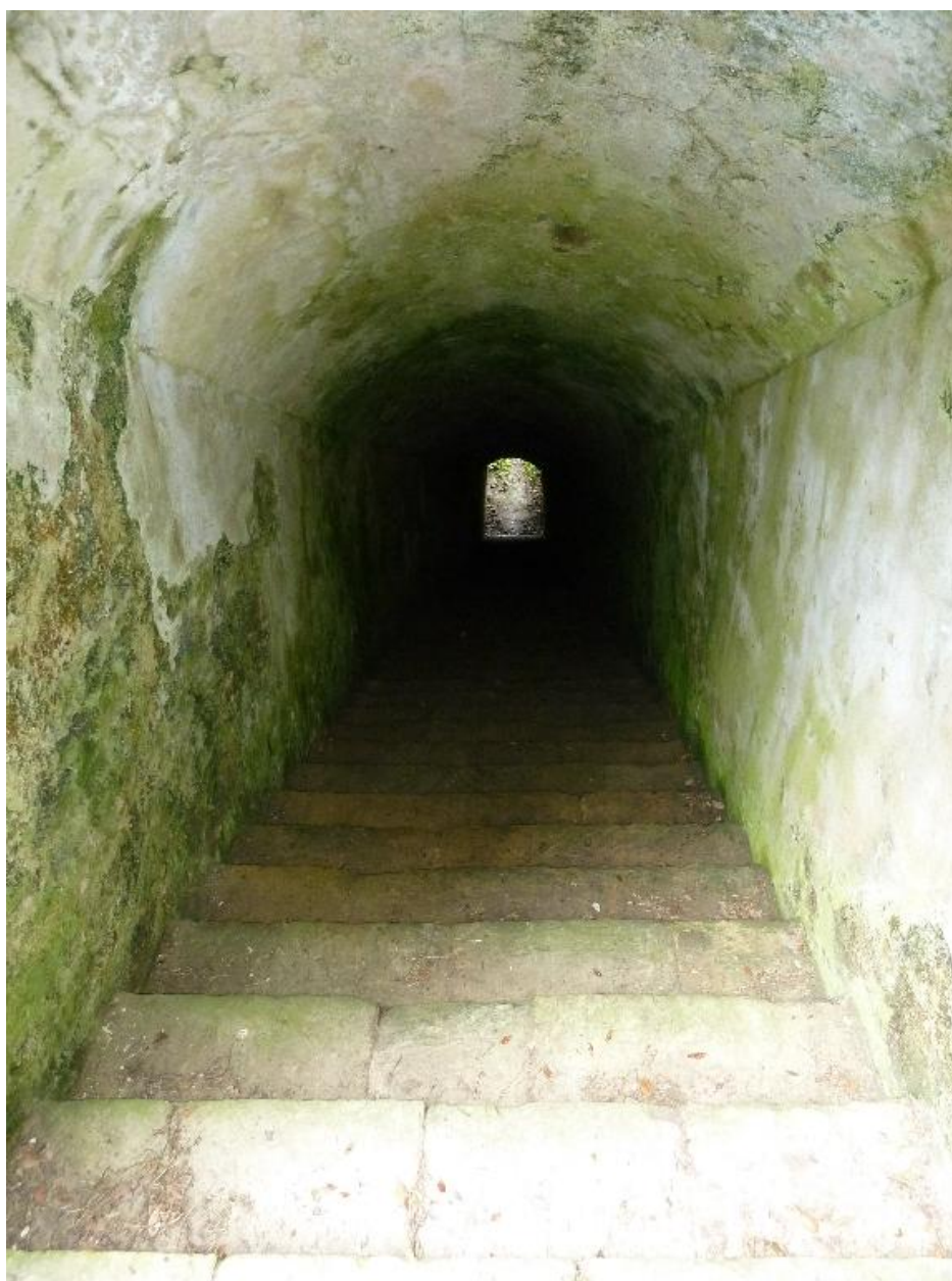
Le Palais, enceinte urbaine, courtine 21-22, galerie intermédiaire.
