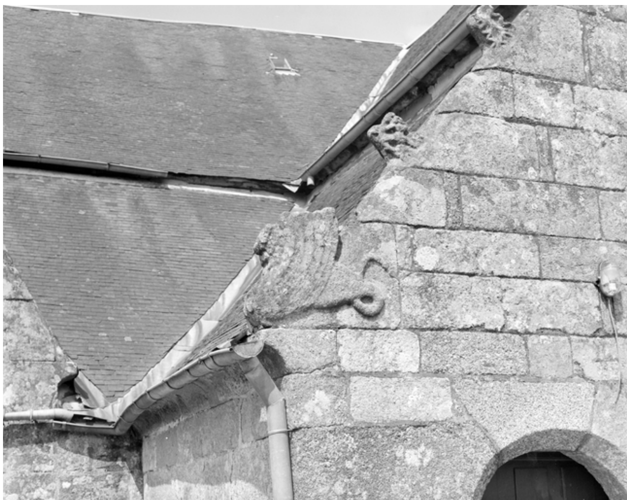
Transept sud : rampant
