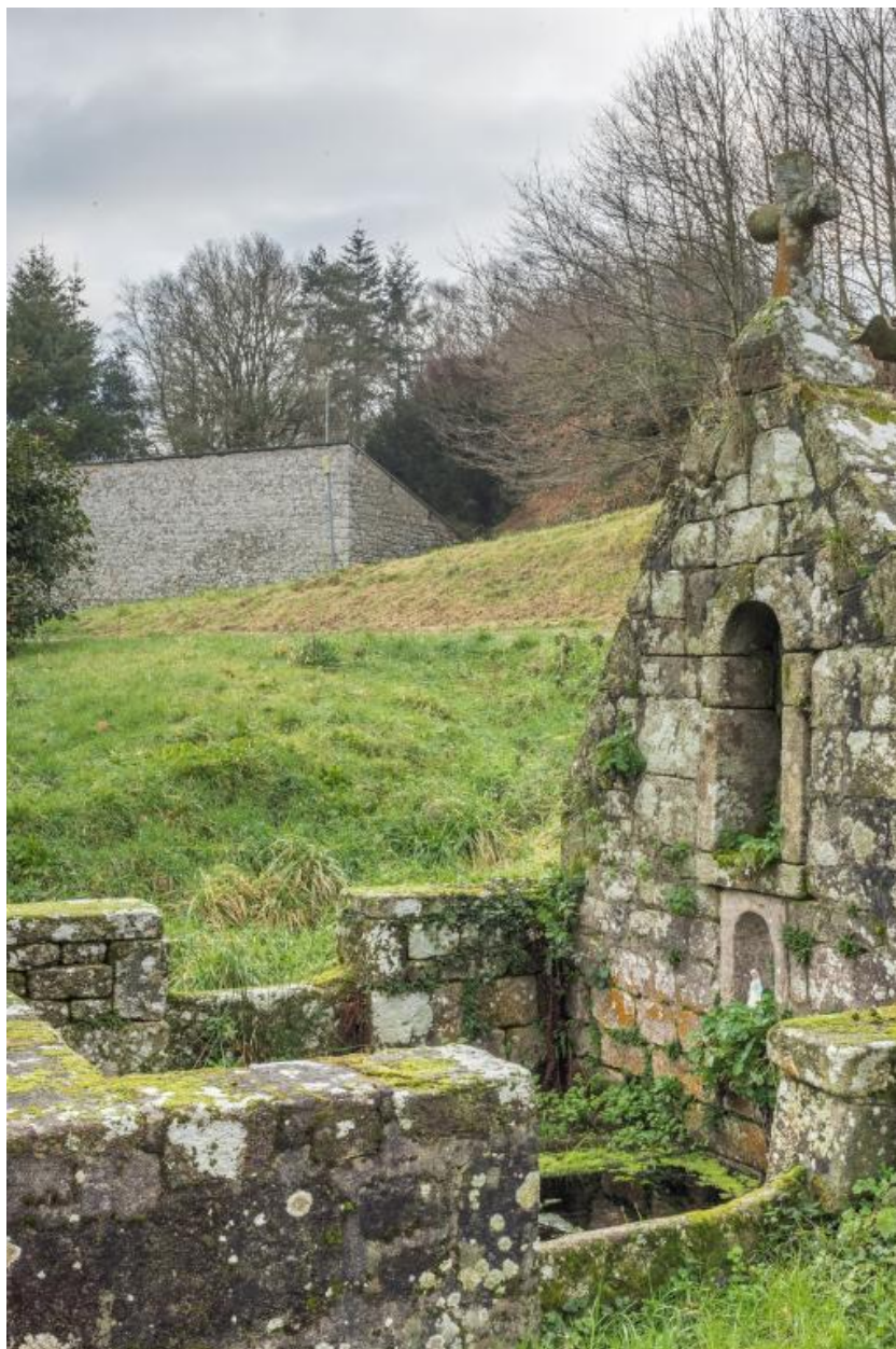
Vue de la fontaine et de son muret d'enceinte depuis l'ouest
