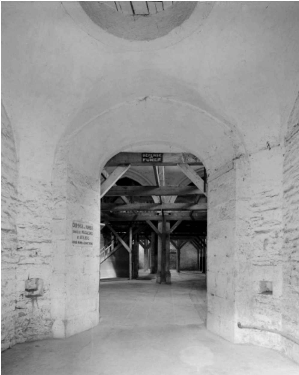
Tour du clocher, porte d'accès
