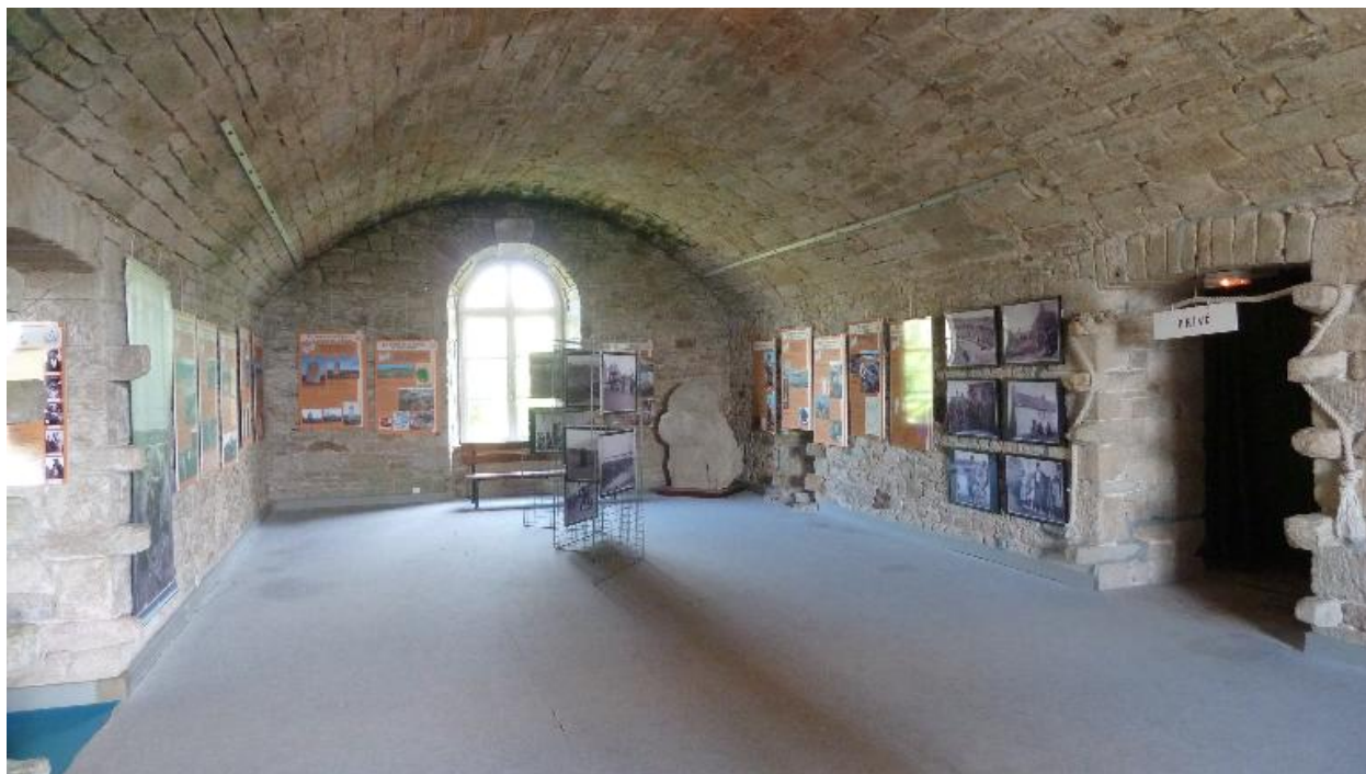
Hoedic, fort central, caserne à l'épreuve, casemate du deuxième étage, logement du commandant du fort.
