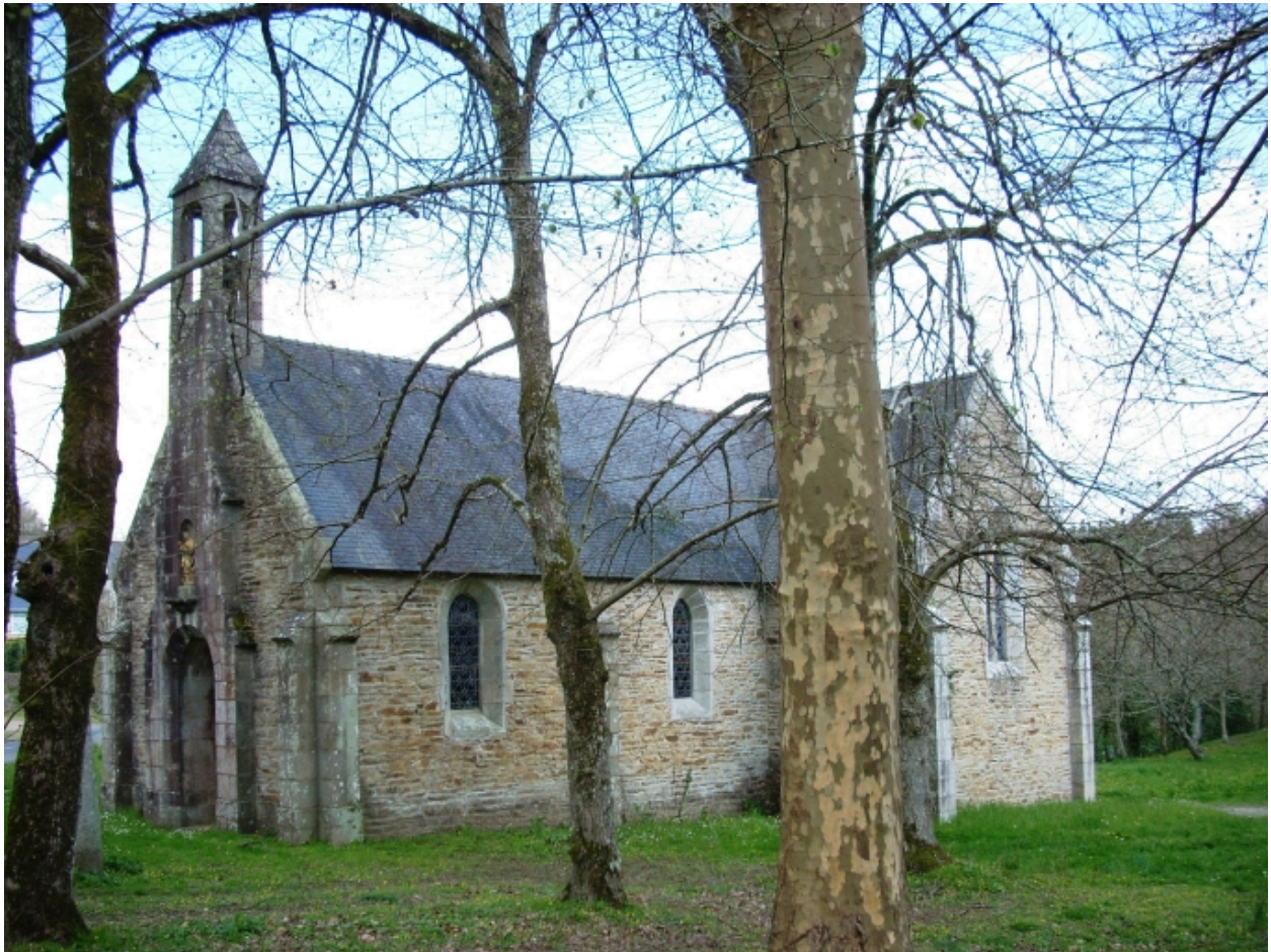
Moëlan-sur-Mer, chapelle de Lanriot : vue générale sud-ouest
