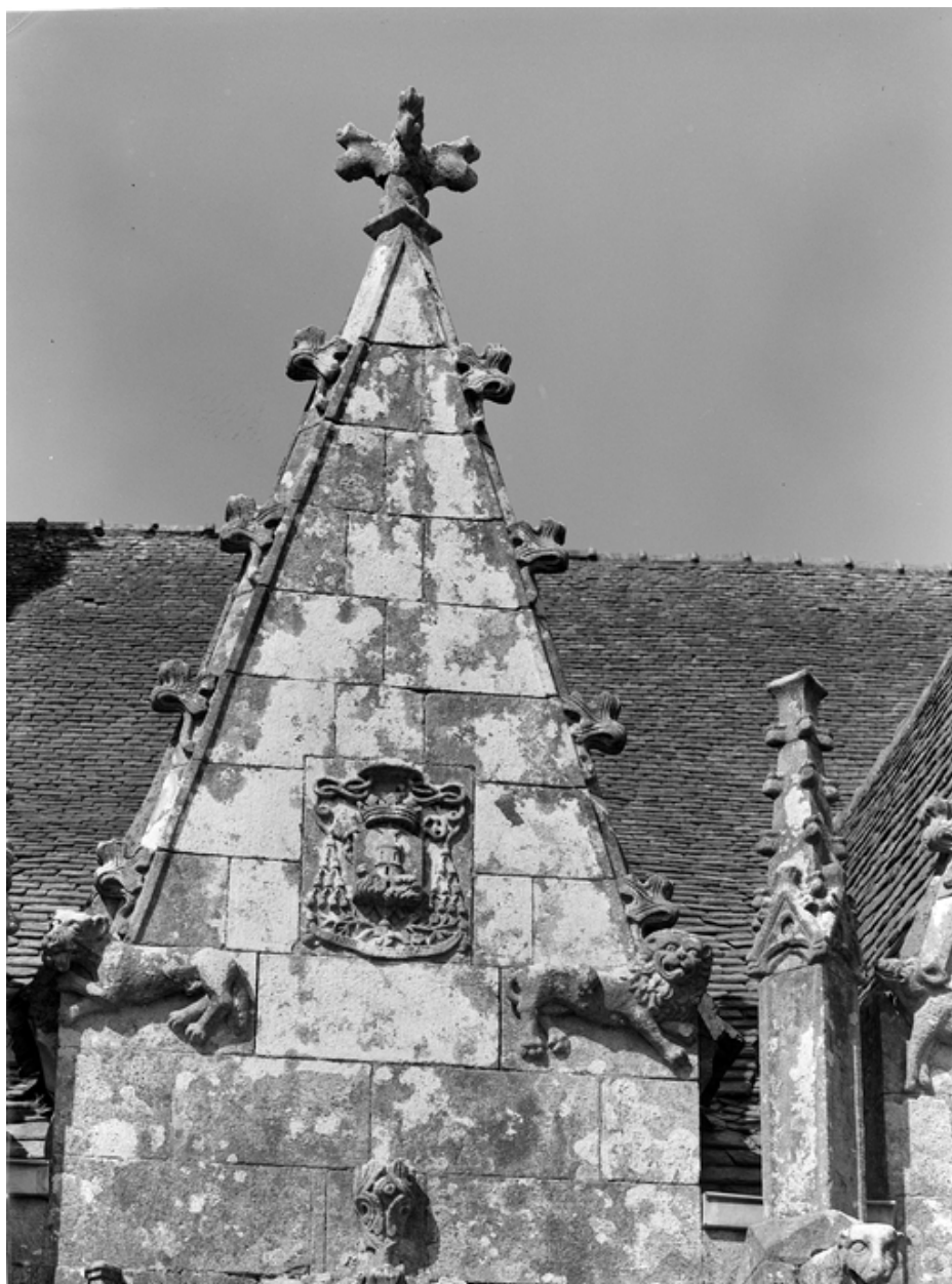
Façade sud, partie ouest : gâble central
