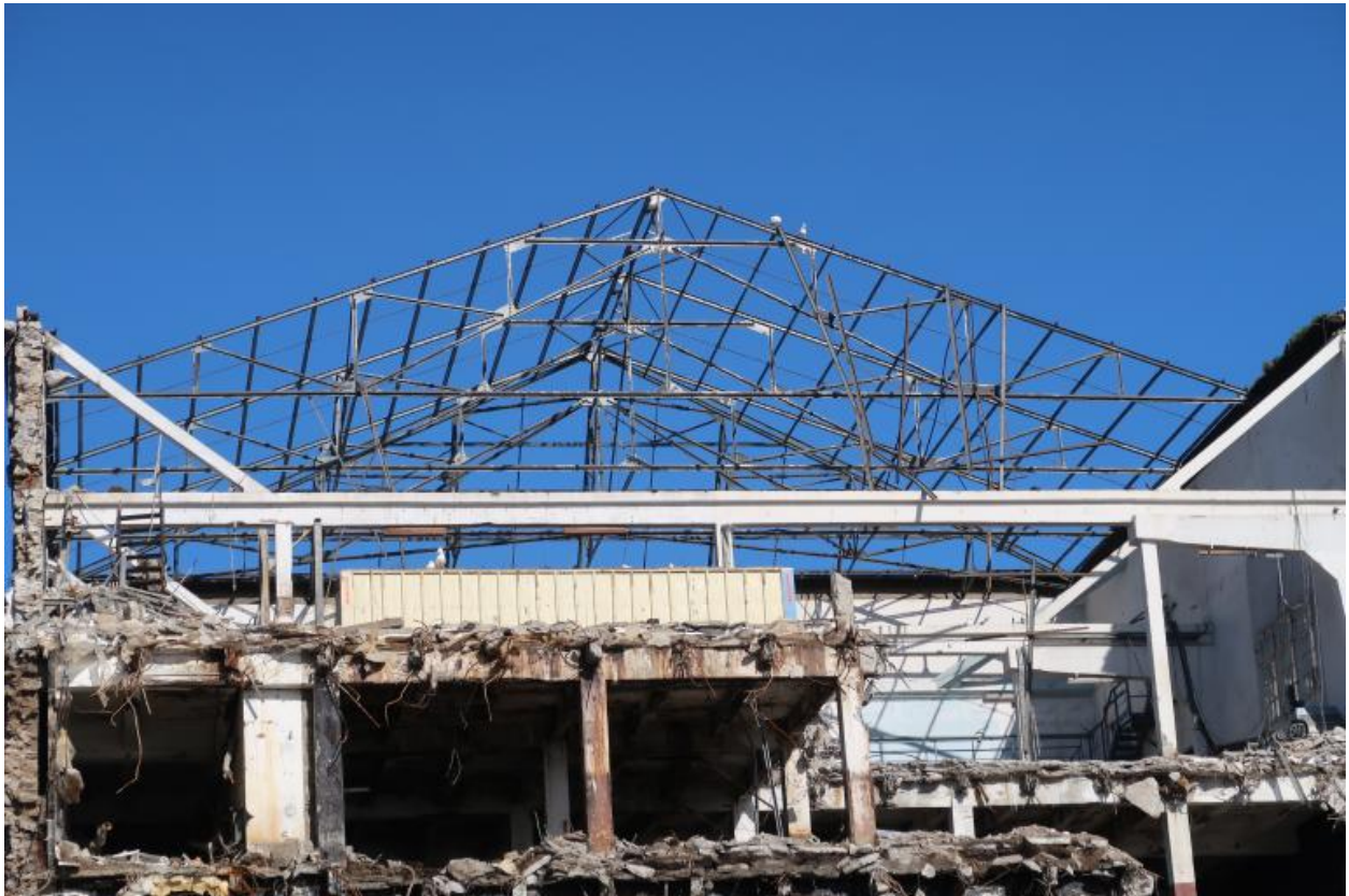
Ancien frigorifique, phase de déconstruction, 10 mars 2022 : charpente métallique, assemblage par rivetage
