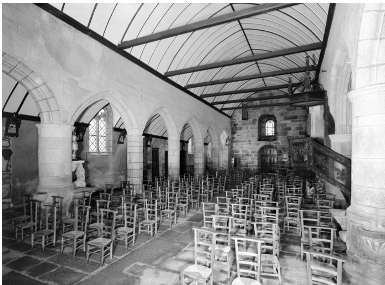
Nef : vue générale sud ouest
