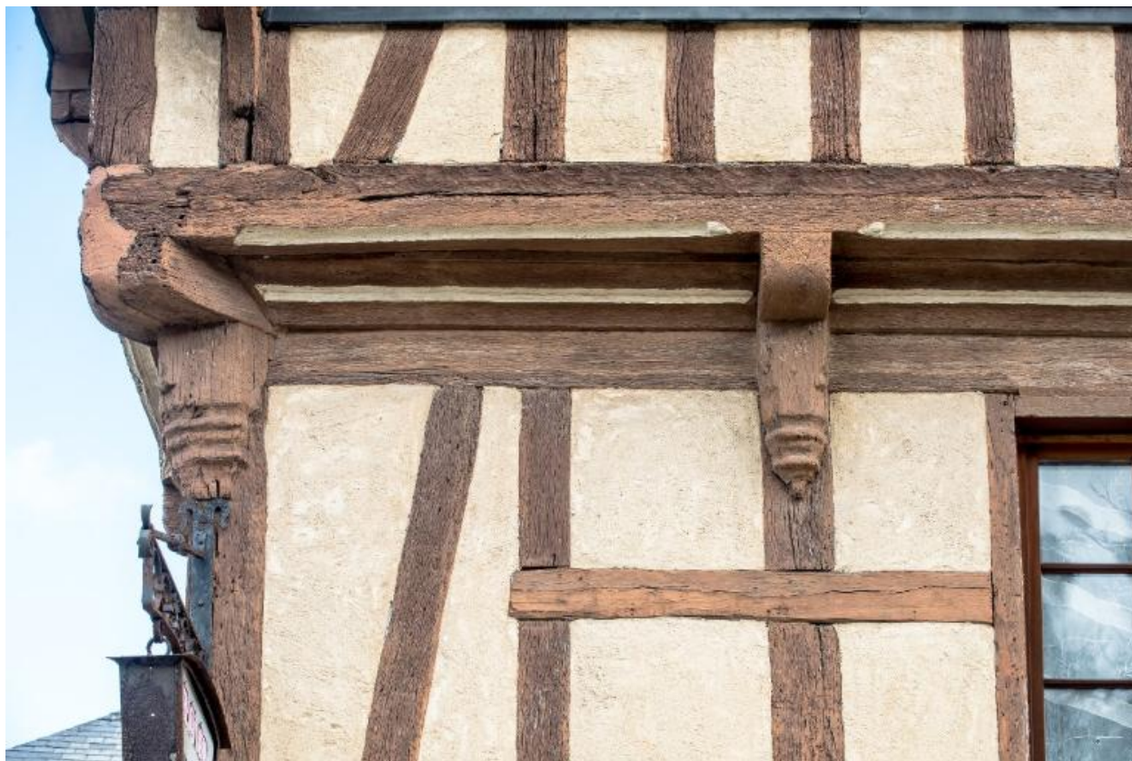
Détail de l'encorbellement d'étage et des consoles.
