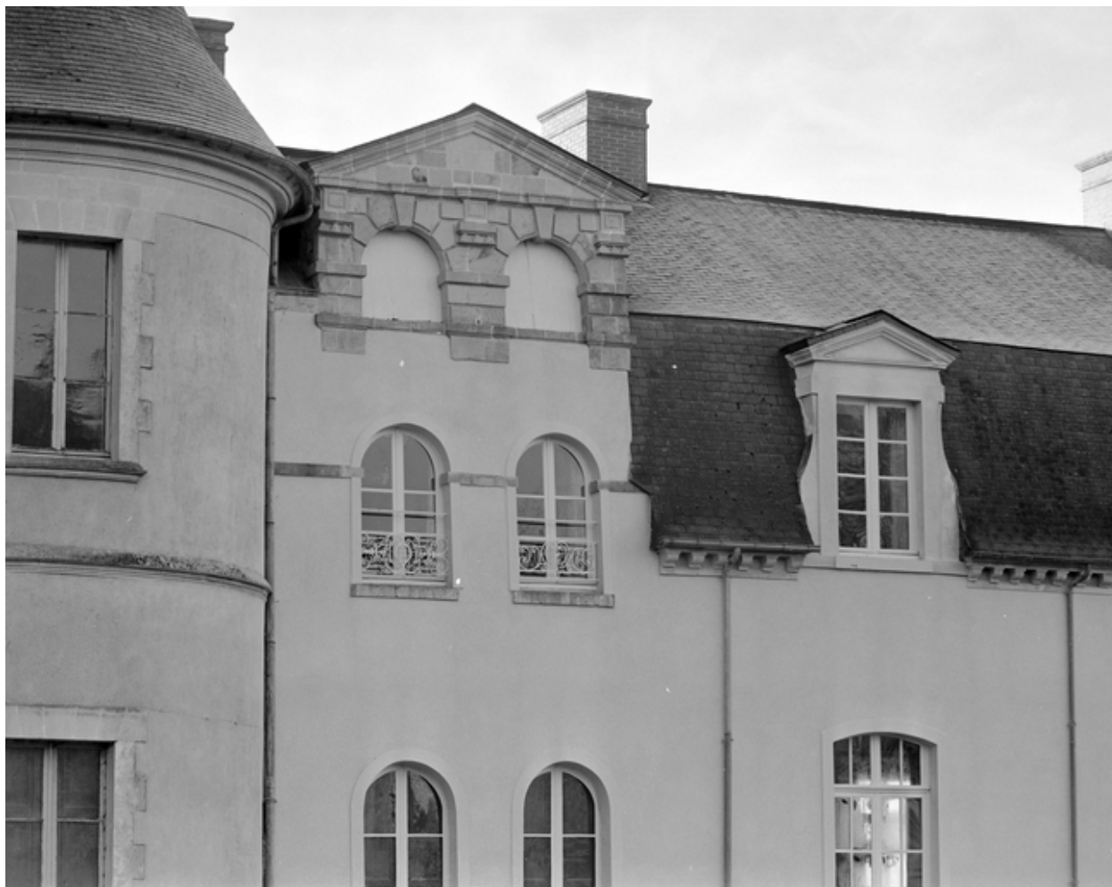
Elévation nord, détail des fenêtres de l'étage.
