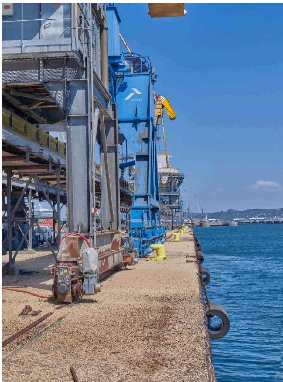
Grues sur rails et chemins de grues
