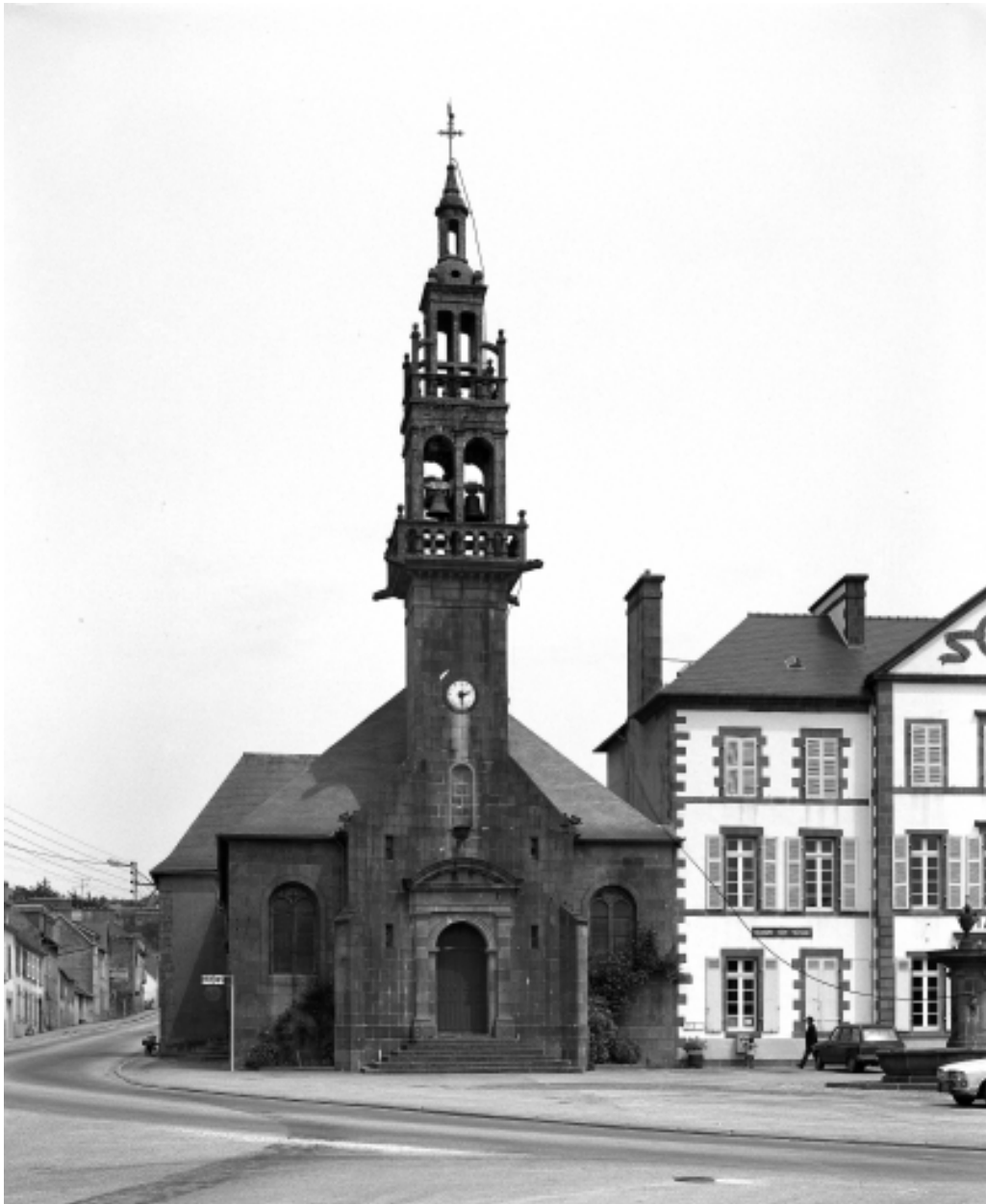
Port-Launay, église paroissiale Saint-Nicolas : façade ouest, état en 1972
